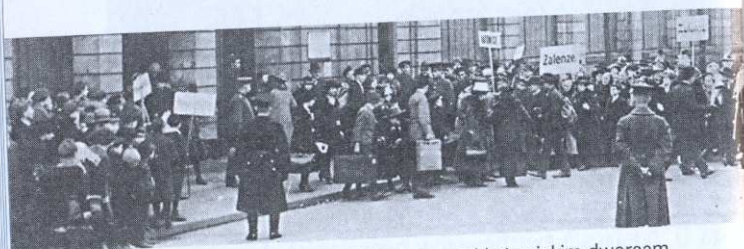
Fot. 3. Niemcy przybyli na plebiscyt przed katowickim dworcem Źródło: W. Szewczyk, Bogucice, Załęże et nova villa Katowice. Rozwój w czasie i przestrzeni , Katowice 1993, s. 38
