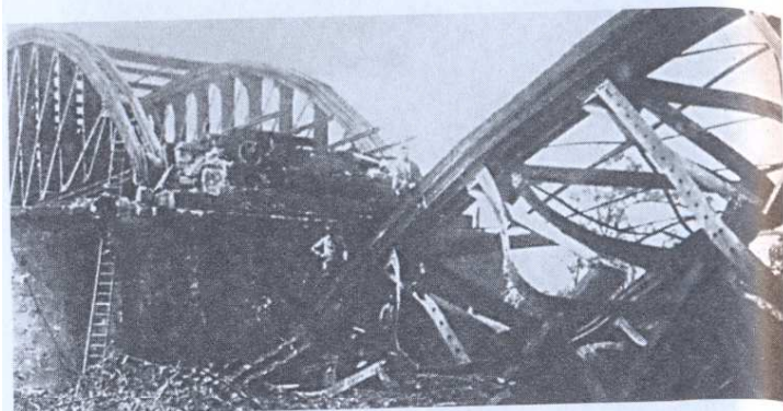
Fot. 23. Zniszczony most kolejowy w Koźlu (maj 1921)
